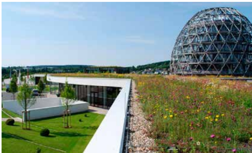
Abbildung 7: Extensive Dachbegrünung (Foto: Optigrün International AG)
