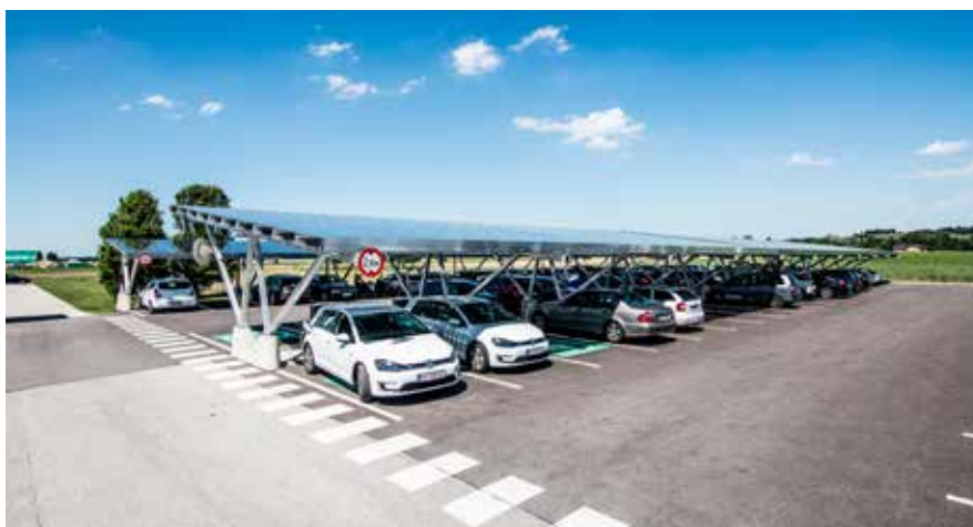
Abbildung 18: PV-Carport am Standort Pettenbach (Foto: Fronius International GmbH)
