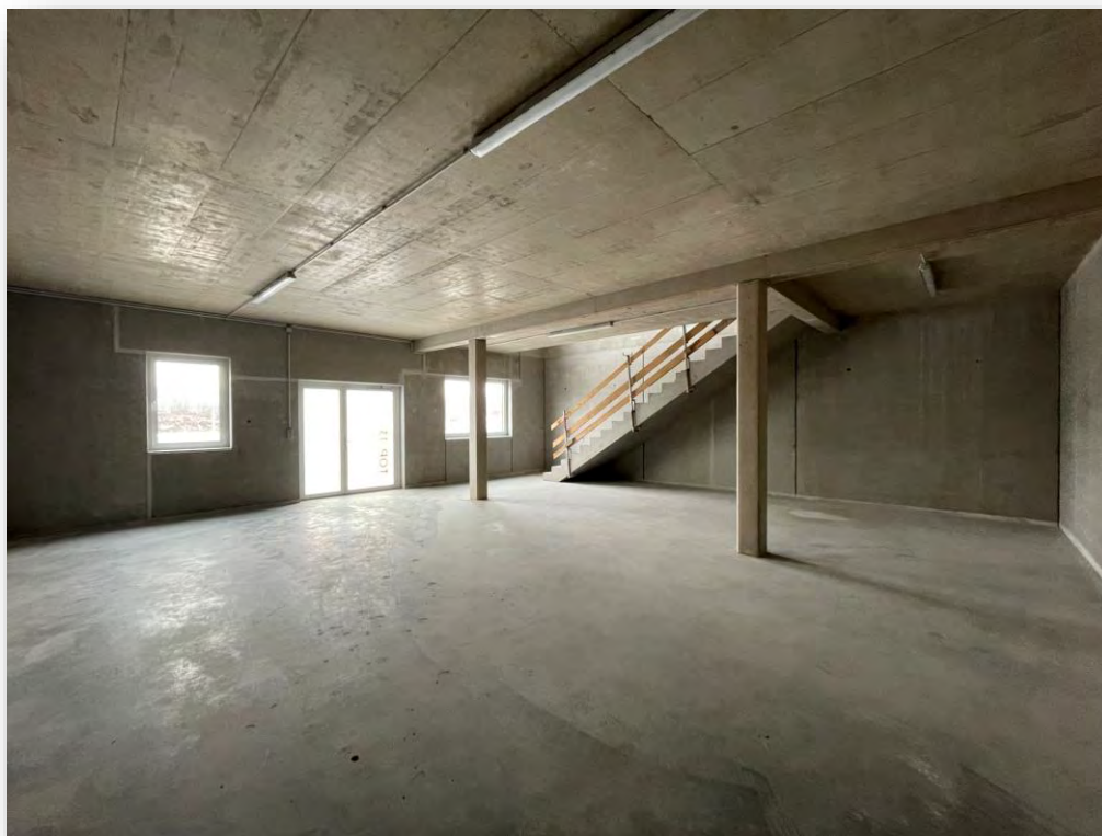
Innenansicht Halle Top 13 - Erdgeschoss
