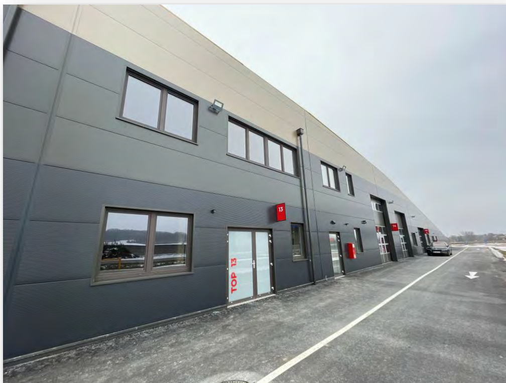
Außenansicht Halle Top 13
